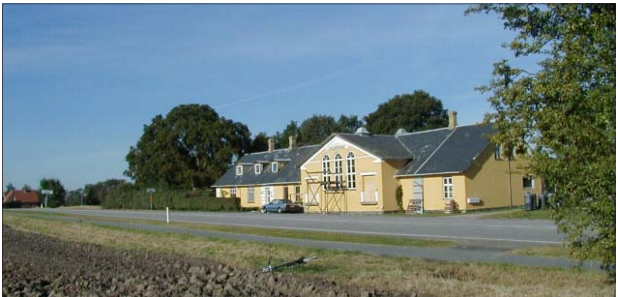
De gamle mejeribygninger set fra Roskildevej.
